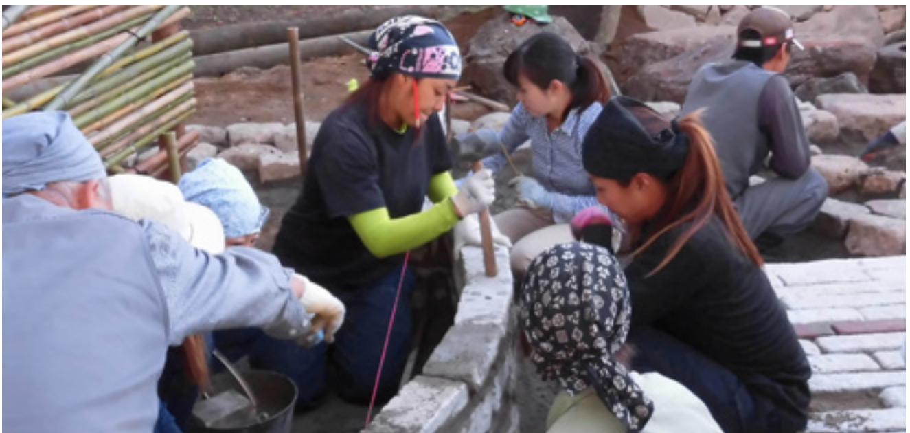
小端積みを施工する女性技能者たち。石を一つ一つ丹念に積み重ねていく
