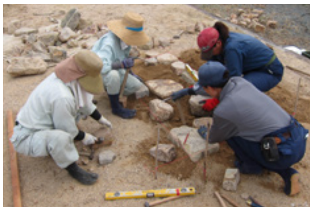
さまざまな道具を使用して敷石を施工する作業。
