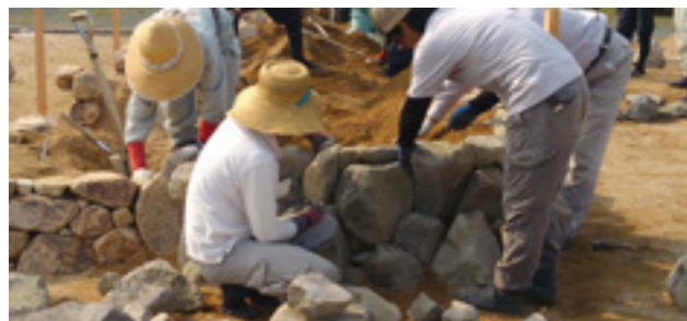
女性たちによる野面積みの施工。重量物は慎重に扱う
