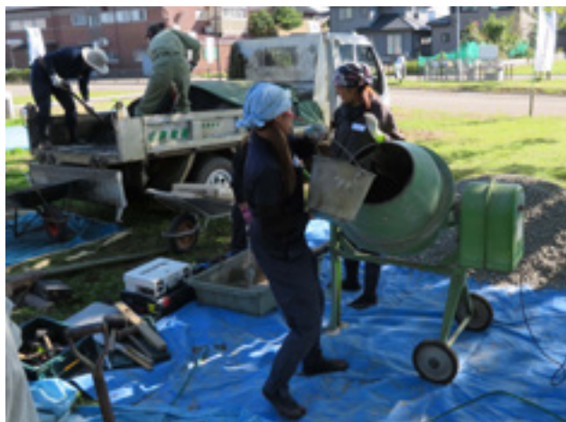
ダンプから土砂を積み降ろし、ミキサーで攪拌する作業
