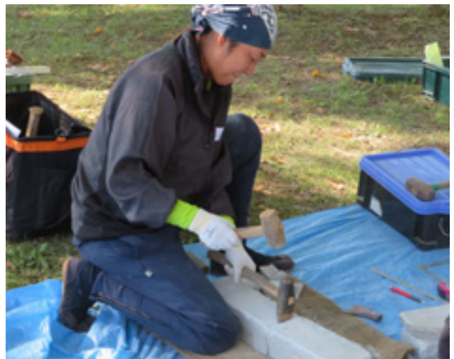
セットウとコヤスケで石を割る作業。セットウの重みで割るという基本をマスターすれば、女性でも楽に割れる
