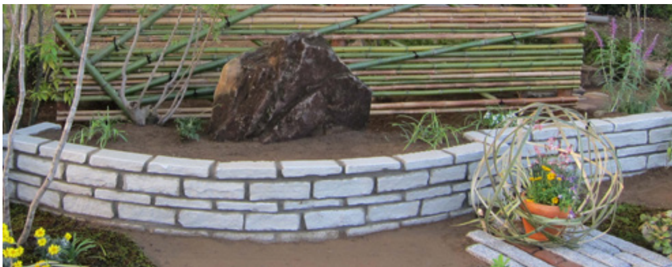
完成した切石の小端積み。モルタルを使った練り積みで施工
