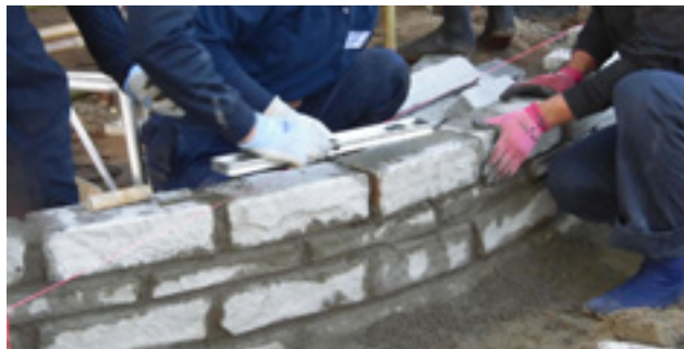
小端積み施工の様子。石を積むごとに水平を確認
