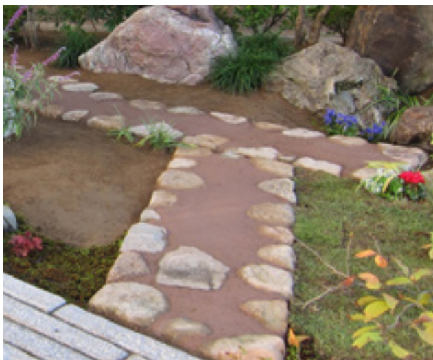
完成した延段。自然石で縁取り、内部は真砂土系舗装
