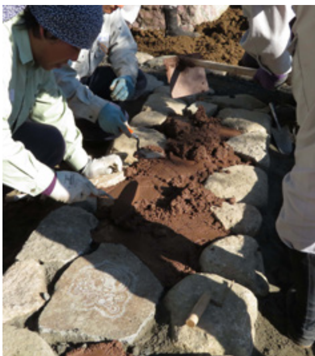
延段の施工。真砂土系で舗装し、レンガゴテで均す
