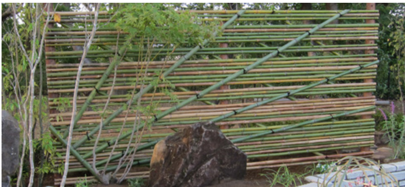
完成した松韻垣。放射状に斜めに取りつけた押縁が特徴。植栽と手前の景石と相俟って趣のある景をつくる
