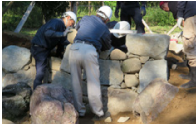
野面積み施工の様子。天端石を積む作業
