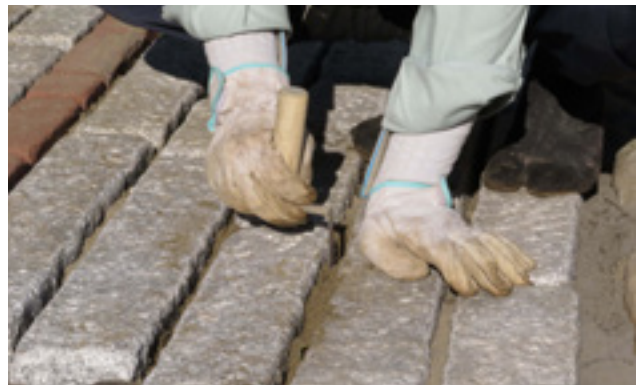
切石の敷石を施工。目地ゴテで目地を押さえる
