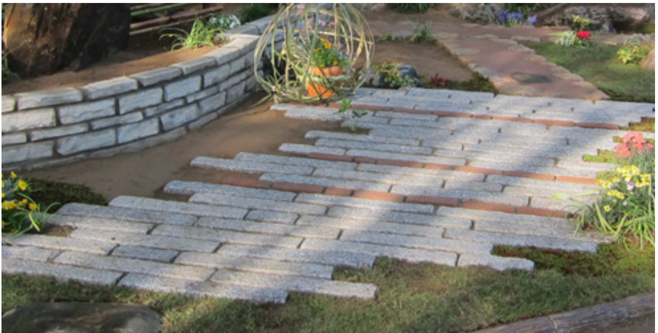
完成した切石の敷石。ポイントに挟んだレンガ敷きが色彩的な変化をつくっている
